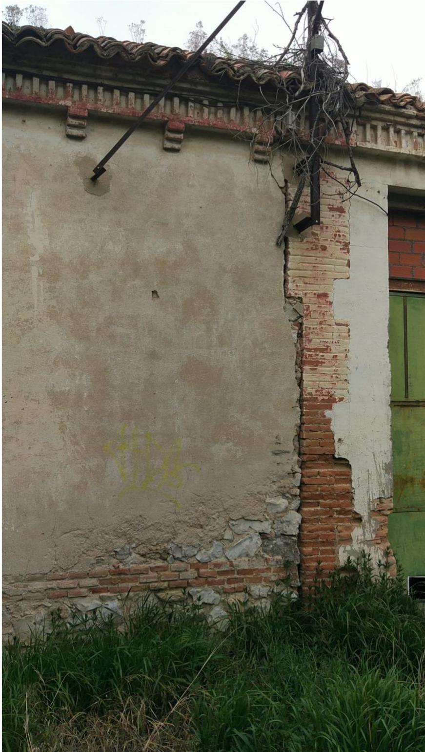
Imagen 4. Vista de la junta que separa las estructuras de la nave central y la nave desocupada. Se puede observar que la ornamentación en la base de la cubierta es inexistente en esta última, lo que puede ser debido a que ambos espacios fueron construidos en diferentes fases.
